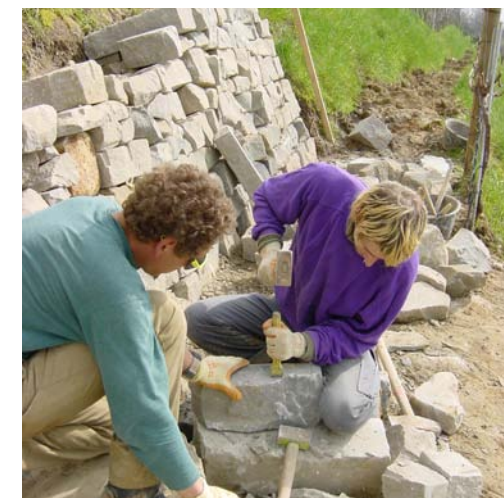
Mauerarbeiten zur Förderung der Schlingnatter
