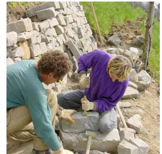
Mauerarbeiten zur Förderung der Schlingnatter
