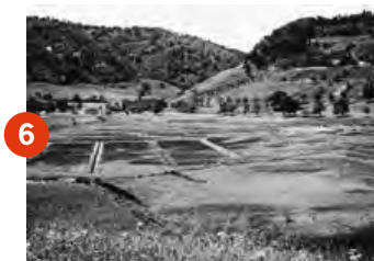
Entwässerung des Weiertals 1921
